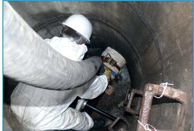
Der Liner wird mit definiertem Druck aufgestellt
