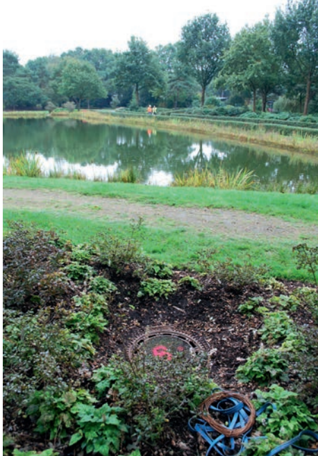
Der Blick über die Trasse des zu sanierenden Kanals unter dem Rhododendron-Park vermittelt einen Eindruck von der Sensibilität des Umfeldes und der Grundwassersituation. Foto: A. zu Eulenburg
