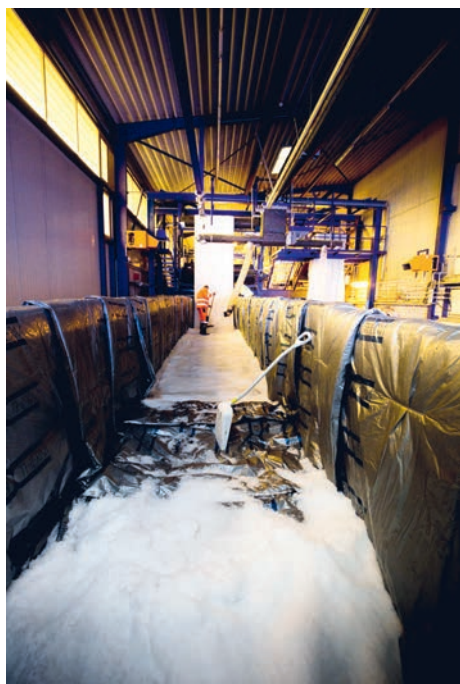
Verladen des Liners direkt aus der Imprägnieranlage in die gekühlte Transportkiste auf dem Sattelzug. | Foto: Aarsleff
