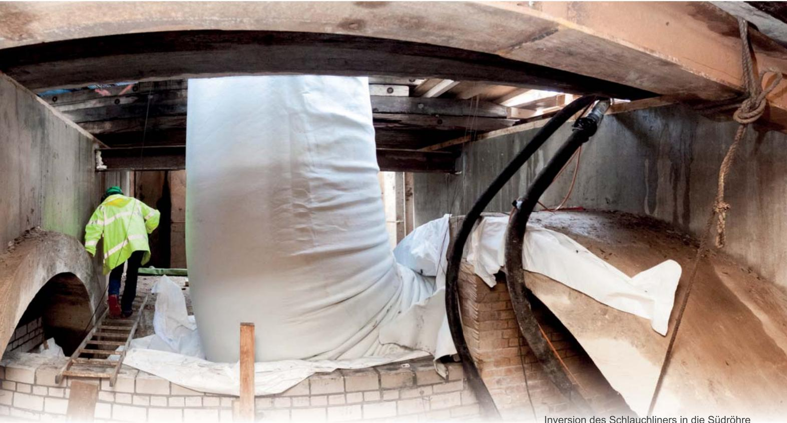
Inversion des Schlauchliners in die Südröhre
