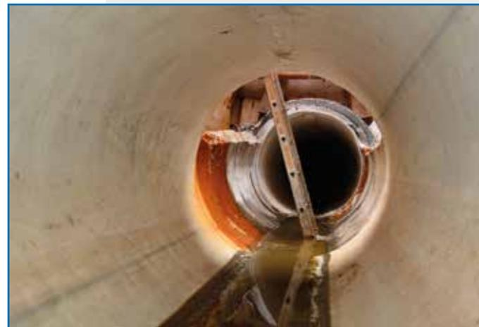
Ausgehärteter Liner DN 1200.
