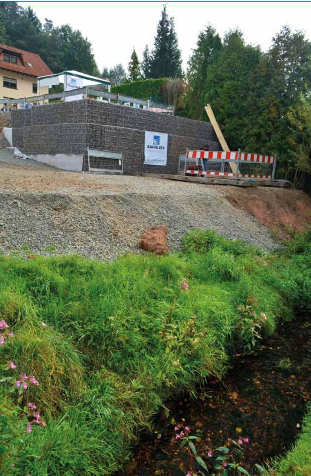
Stabiler Bau: Diese Plattform am Inversionspunkt nahm den Förderturm und den Liner-Transport auf.
