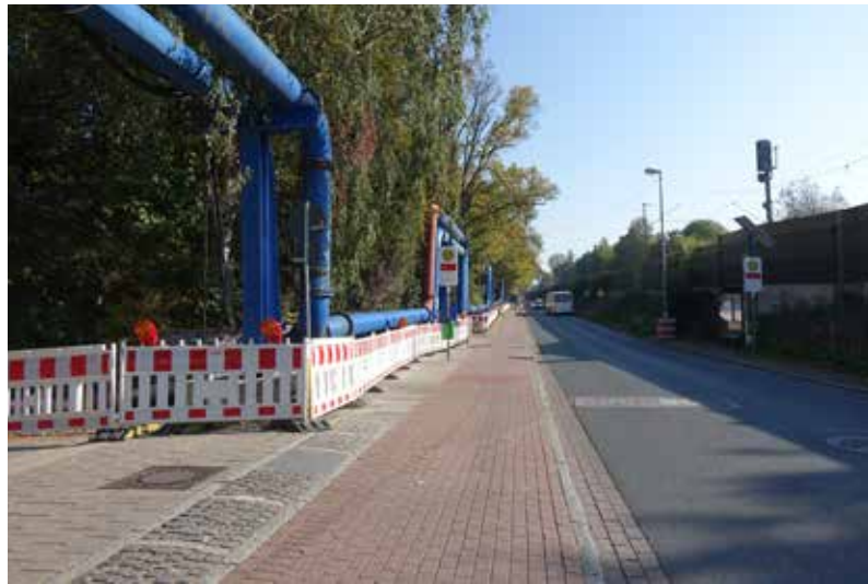
Die komplexe Kanalsanierung war mit umfangreichen Maßnahmen zur Vorflutsicherung verbunden.
