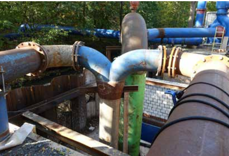
Aufgrund einer Torfschicht unter dem Sammler erwies sich die Herstellung der Baugruben als aufwändiger wie ursprünglich geplant.
