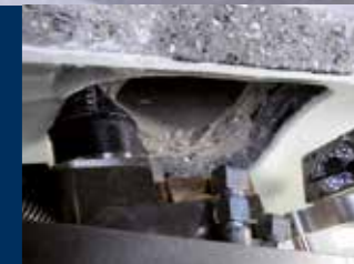
ZULÄUFE ÖFFNEN IM SCHLAUCHLINER
