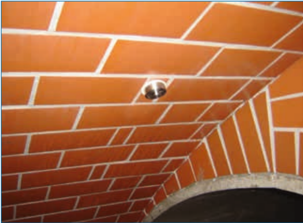
Mit Kera-Line-Platten ausgekleidetes Bauwerk
