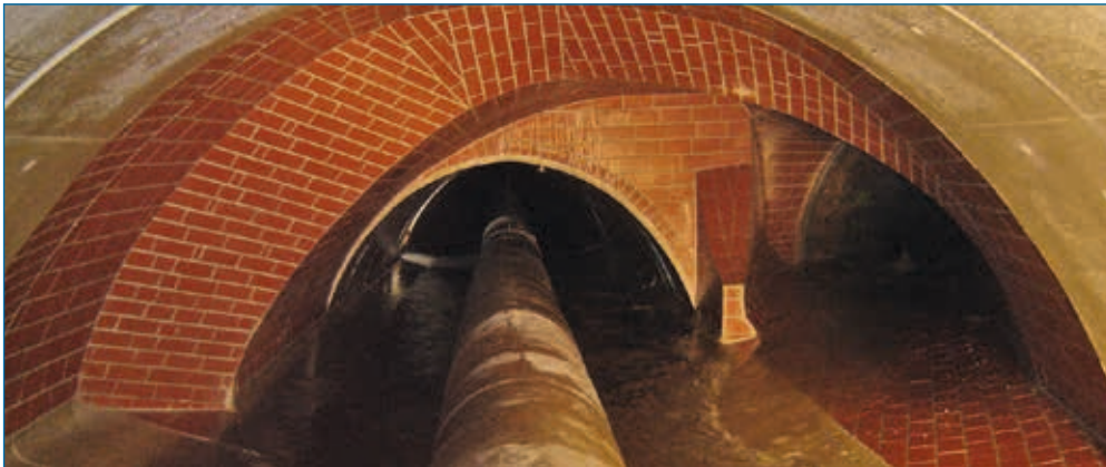
Mit Keramikplatten ausgekleidetes Bauwerk
