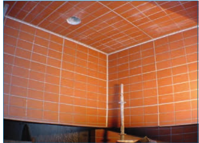
Mit Klinkerplatten ausgekleidetes Bauwerk
