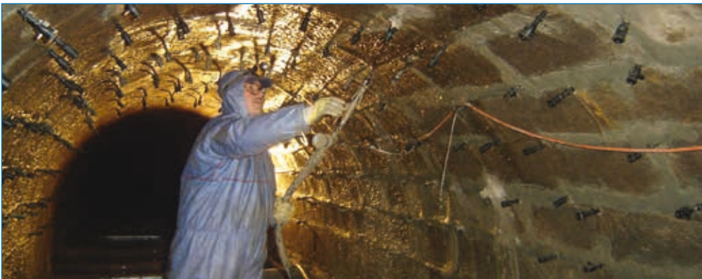
Mineralische Verpressung der Kanalwände
