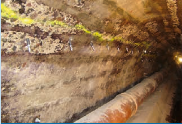
Rissanierung mit PU-Harz
