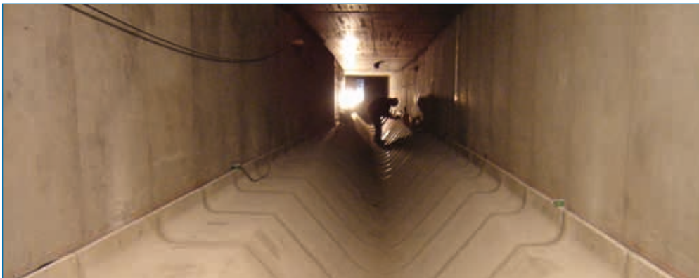
Auskleidung des Sohlbereichs mit Polymerbeton-Elementen
