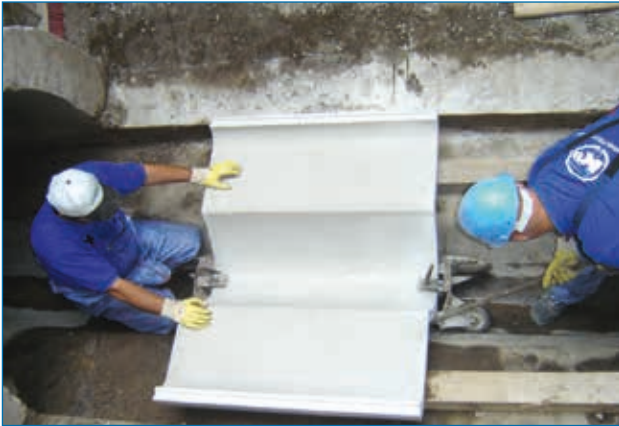
Einfahren des Polymerbeton-Sohlschalenelements
