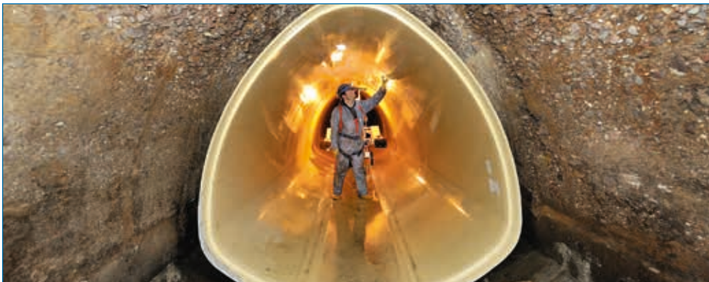
Montiertes GfK-Rohr im Altkanal
