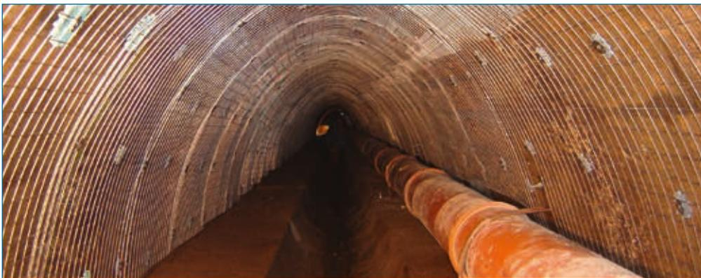
Sanierungsabschnitt im Bauzustand mit innenliegender Wasserhaltung
