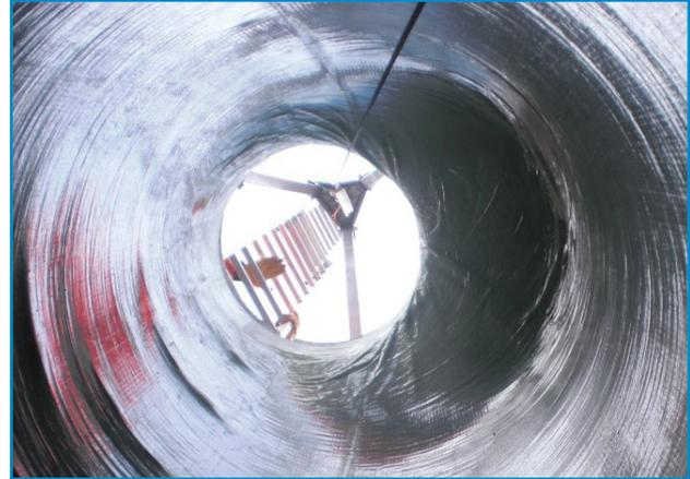
Eingebauter PA-Schachtliner® mit Stützmannschette
