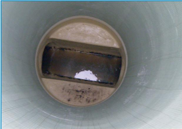
Installierter PA-Schachtliner® mit Boden mit Ortlaminat
