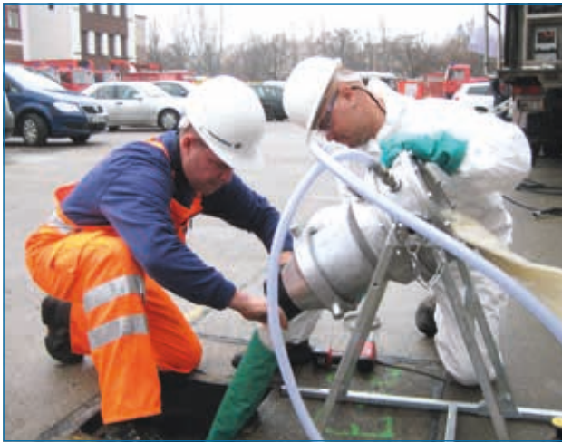
Vorbereitung der Inversion des Liners
