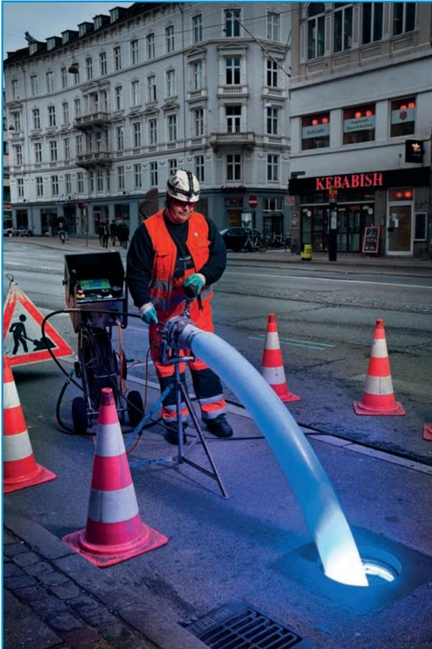
Installation eines Synthesefaserliners DN 200
