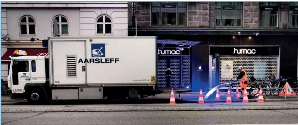
LED-Lichthärtung des Schlauchliners
