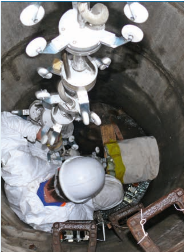
Einbringen der Lichterkette
