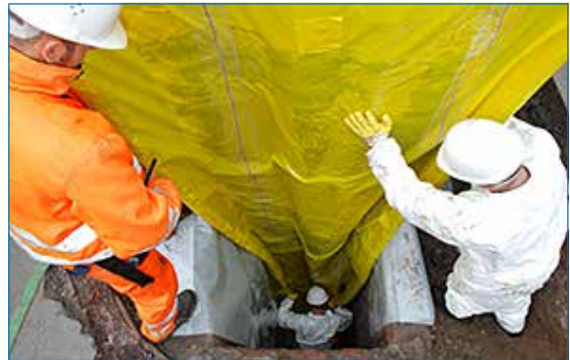
Materialschonender Einbau Liner DN800 mittels Einbauhilfe
