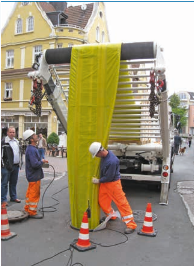
Installation eines Ei-Profiles DN 500/700
