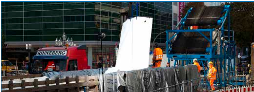
Liner-Inversion mittels Förderband aus einem Schwerlasttransporter
