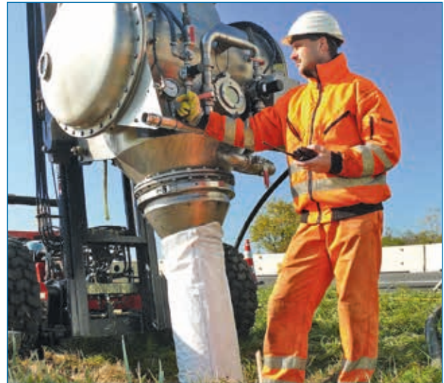
Inversion mittels Einbauroboter (Dampf-Warmhärtung)
