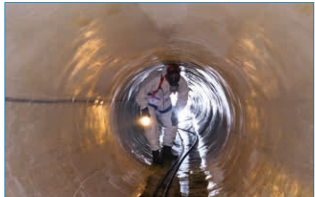
Sanierter Mischwasserhauptsammler DN 1600
