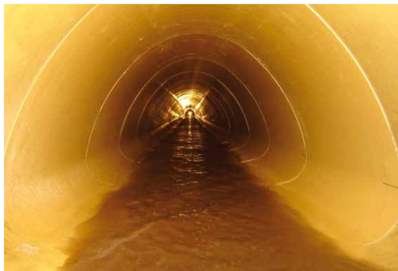
Fertig eingebaute Elemente.
