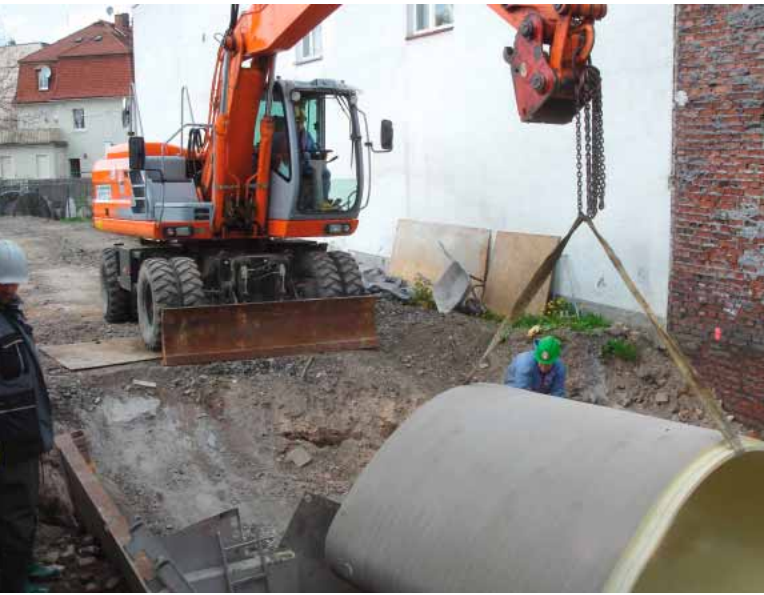
Die GFK-Elemente wurden mit einem Bagger in die Montageöffnungen gehoben...
