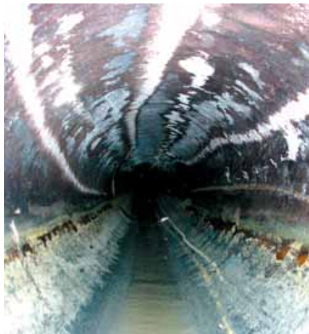
Der Sammler in der Hamburger Holzmühlenstraße: Nach 24 Jahren Kanalbetrieb befindet sich der Schlauchliner sowohl was die Materialkennwerte als auch was den Verschleiß betrifft in tadelloser Verfassung.
