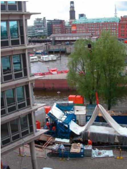
Schlauchlining ist aus den Sanierungsstrategien vieler Netzbetreiber nicht mehr wegzudenken.
